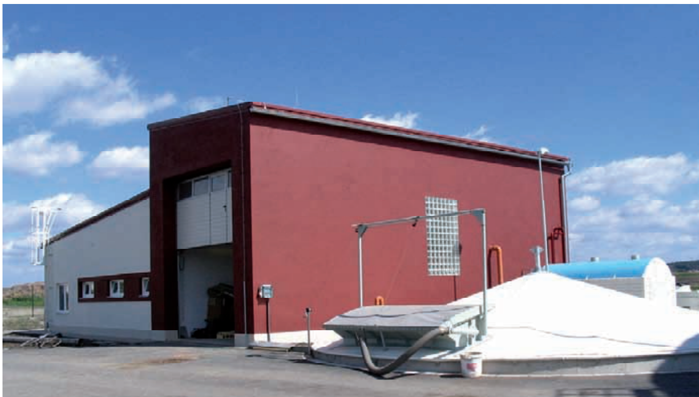
Vstupní objekt na zpracování a hygienizaci odpadů - BPS Kněžice
